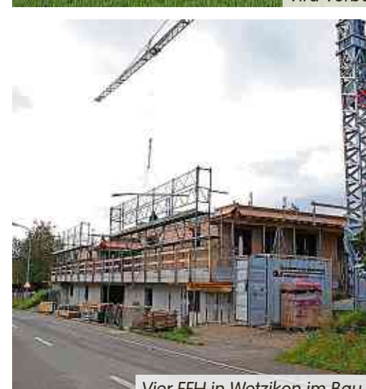
Vier EFH in Wetzikon im Bau
