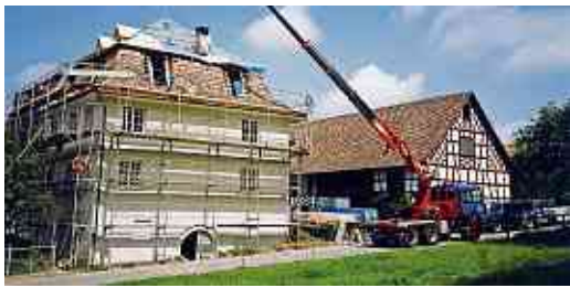
Baustelle 1992: Totalsanierung und Dachrenovation
