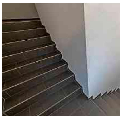
Um jeden Schritt beim Bauprojekt kümmert sich der Chef selber.
