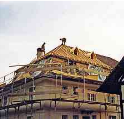
Zimmereiarbeiten auf dem Dach
