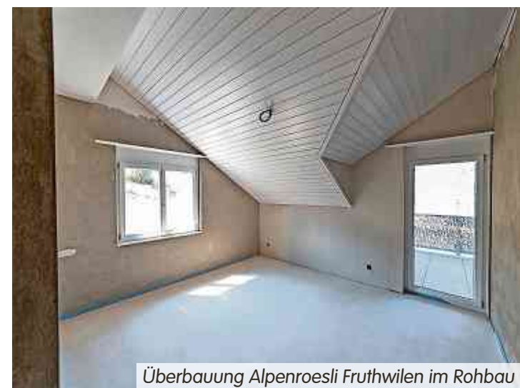
Überbauung Alpenroesli Fruthwilen im Rohbau
